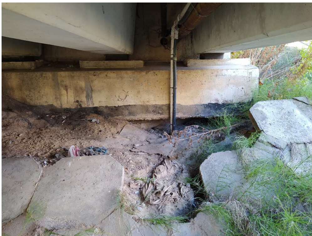
22 pav. Paplautas patiltės tvirtinimas kairiajame krante ištekėjimo pusėje.
