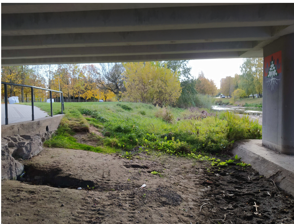
25 pav. Paplauta ir deformuota patiltė dešiniajame krante ties pėsčiųjų taku.
