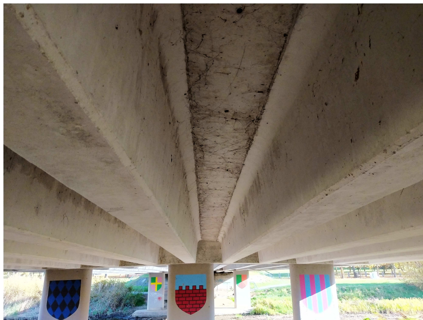
12 pav. Pagrindinės tilto sijos nuo kairiojo kranto
