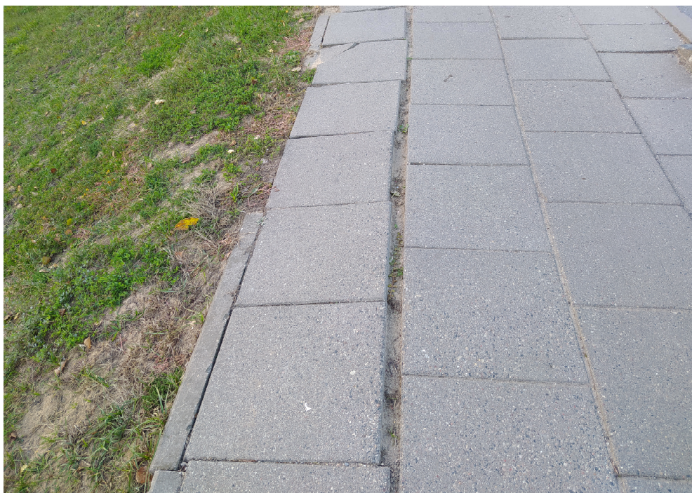
4 pav. Šaligatvis (tilto prieigos) kairiajame krante.
