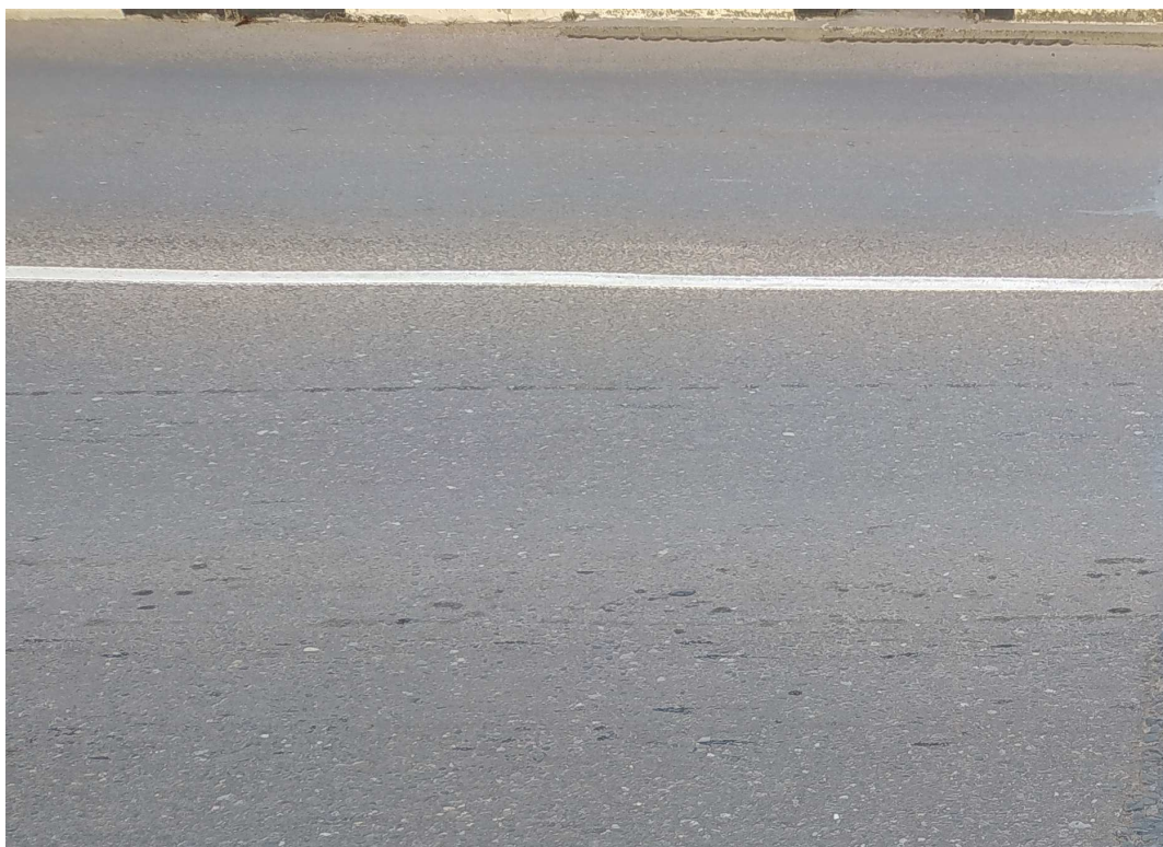
6 pav. Tilto pravažiavimo dalies danga.
