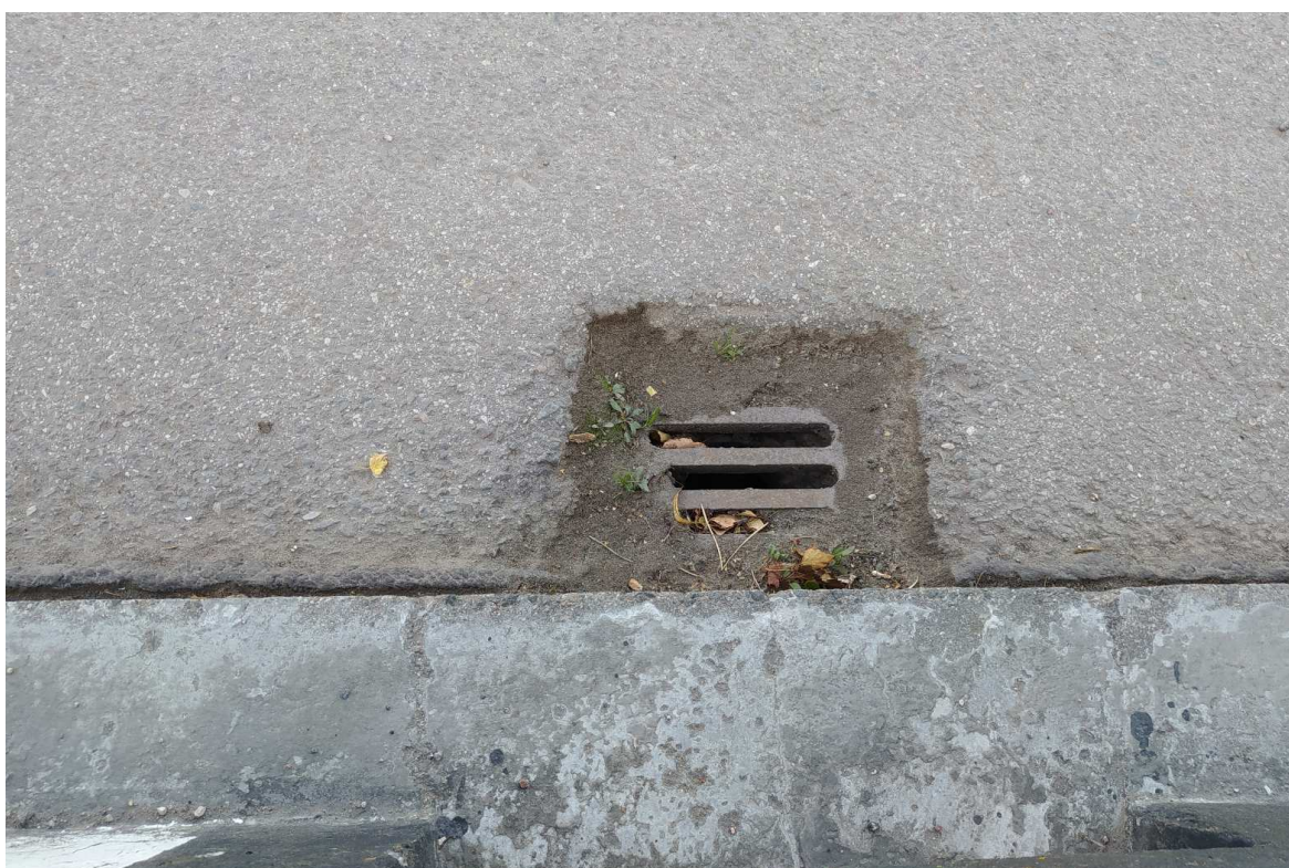
8 pav. Vandens nuleidimo šulinėlis.
